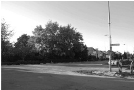
Reconstructie Rijksweg Malden
